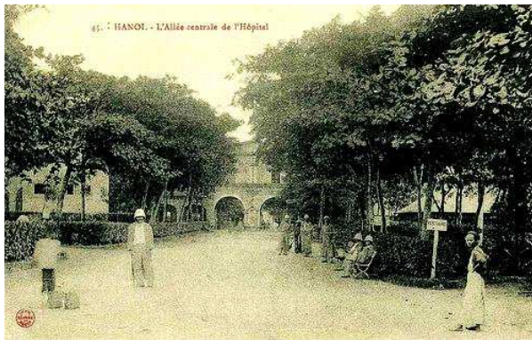
L'allée centrale de l'hôpital de Lanessan à Hanoï (DR)
