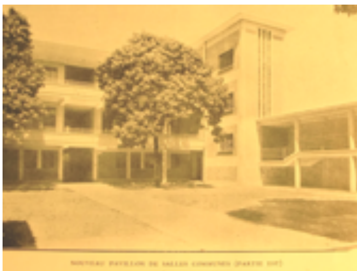
Hôpital Paul Doumer pavillon de salles communes, partie Est (DR)
