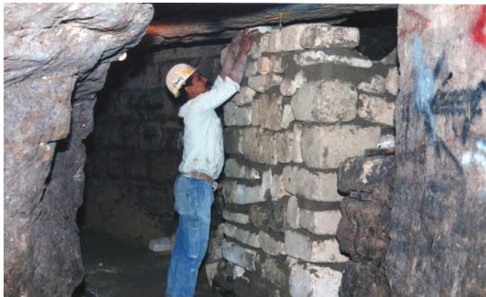
Le chantier de restauration<sup>4</sup> se déroulait à partir de 1990 avec la confortation des piliers tournés et l'édification de piliers et de voutes de consolidation. Si l'escalier de Mansart permet l'exploration des carrières, il ne permet pas une mise en œuvre ergonomique des travaux.
